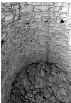
Interior de la torre amb forats per encaixar les bigues de fusta
