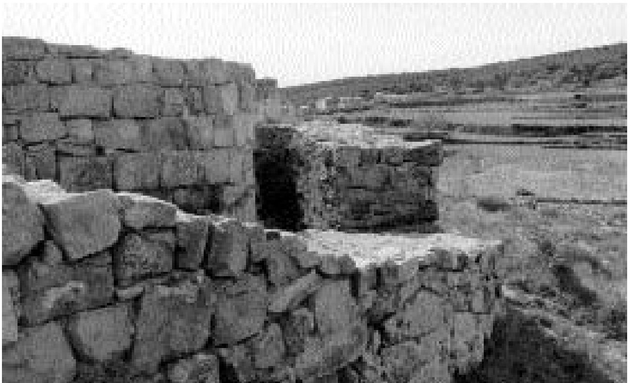
2.- Vista del acceso en la actualidad.
