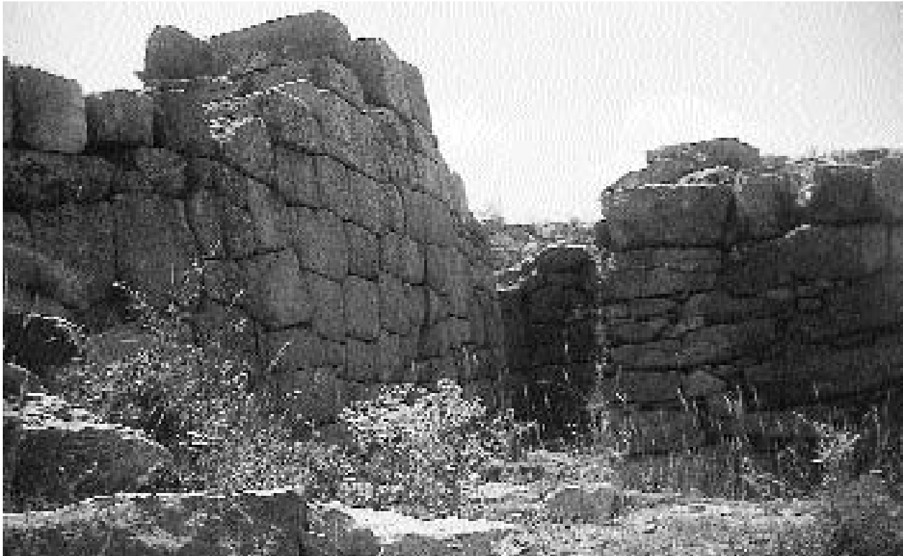
1.- Estado de la torre en el año 1971.
