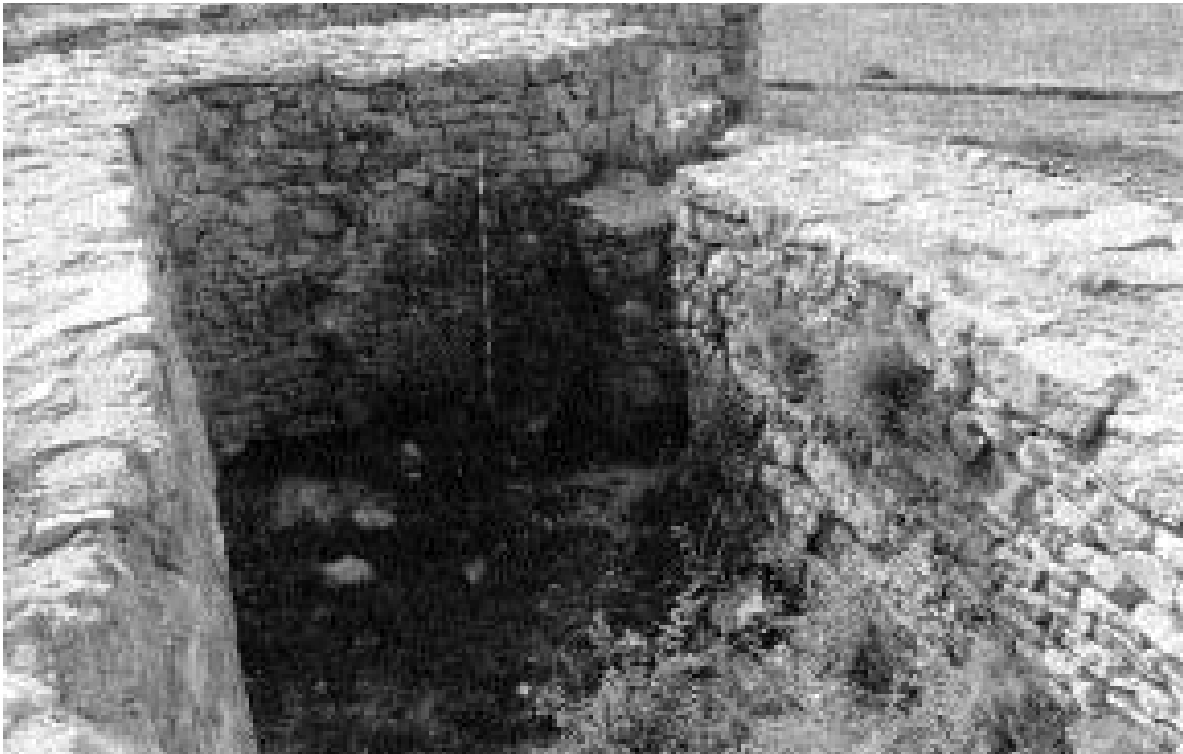
1.- Vista de la zona IV en el interior de la torre.
