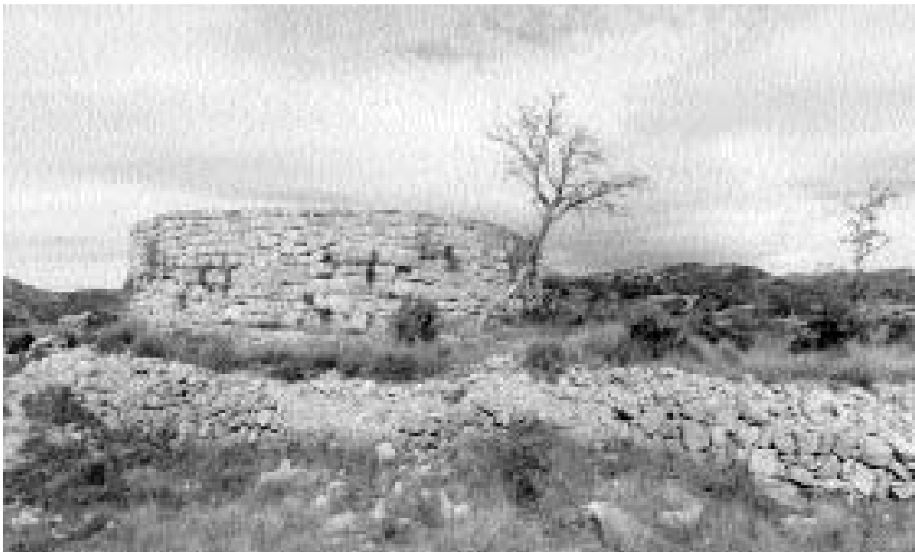
2.- Estado actual de la estructura turriforme.
