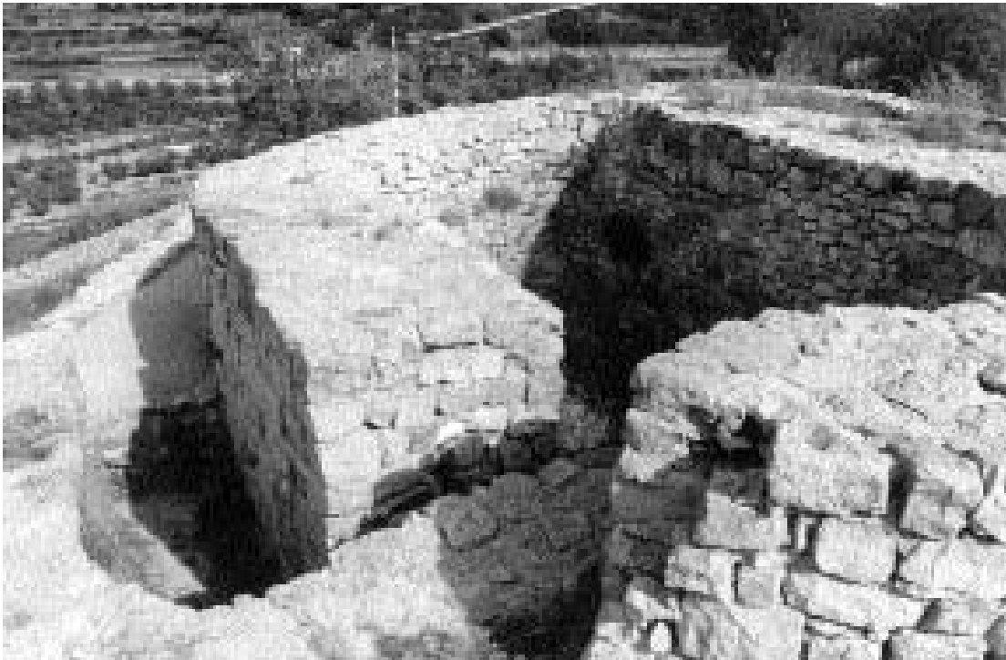
2.- Vista del acceso al interior de la torre.
